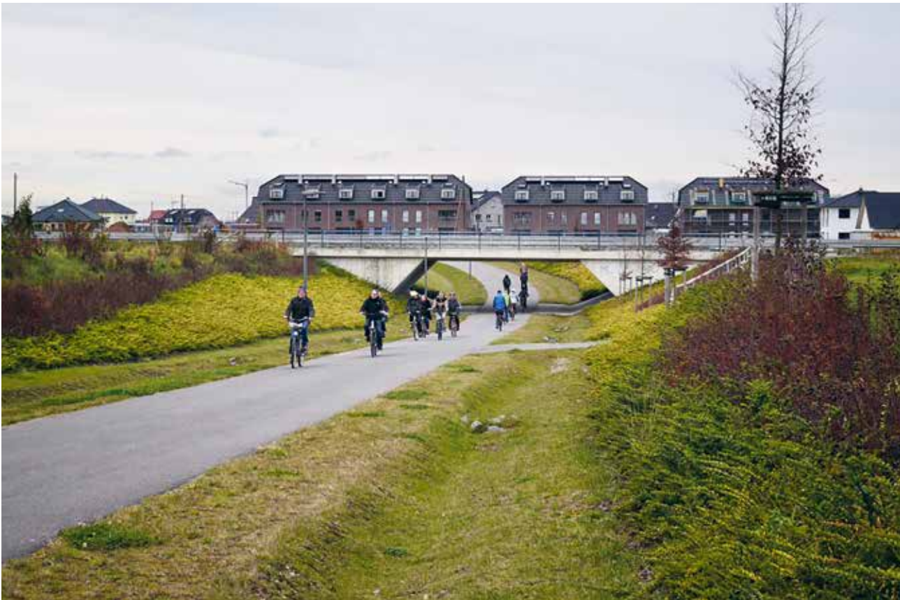
Abbildung 41: Einsehbarkeit Unterfahung K 17 Kerpen-Manheim-neu aus Osten (Bild: Kolpingstadt Kerpen)
