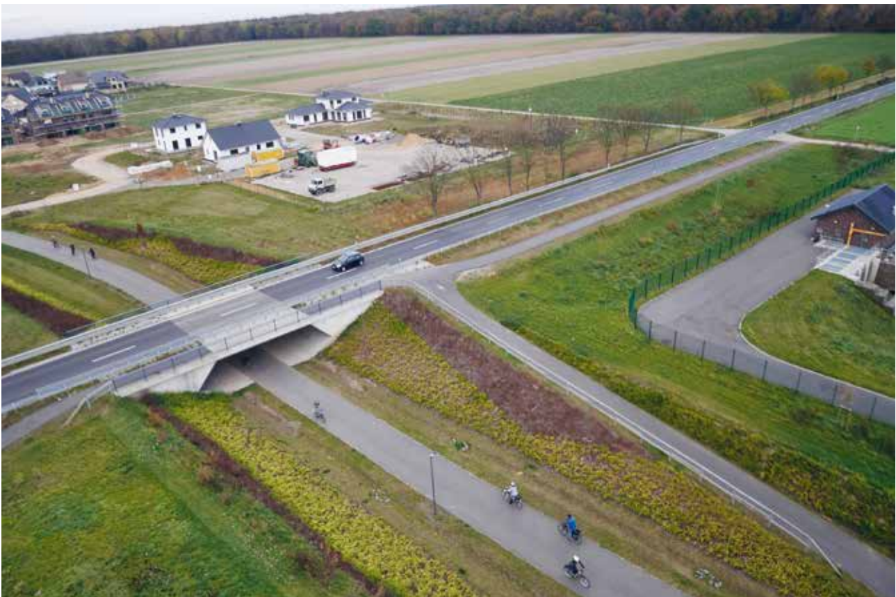
Abbildung 40: Luftbild Unterführung K 17 Kerpen-Manheim-neu (Bild: Kolpingstadt Kerpen)
