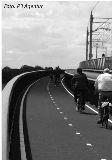
Fahrradbrücke entlang einer Eisenbahnlinie in Zwolle
